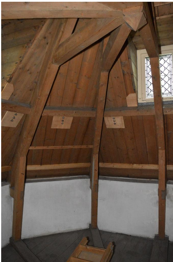
De kapconstructie van de noordelijke sacristie van de kapel, bestaande uit een spant en vier waaierend geplaatste halfspanten. Het leibeschet is op de muurplaat, gordingen en nokbalk getimmerd.
