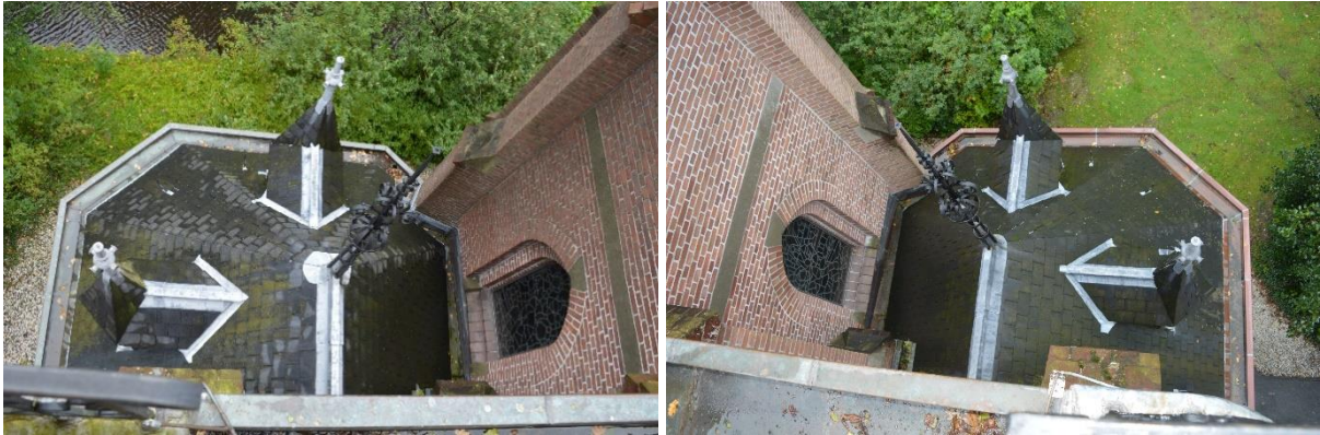
Links: het dak van de zuidelijke sacristie.
