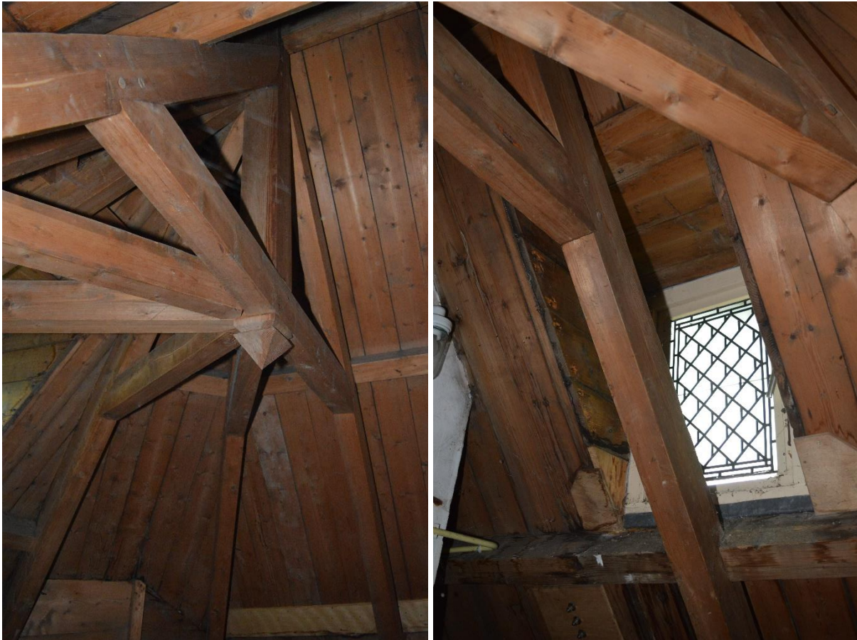
Links: de kapconstructie van de zuidelijke sacristie van de kapel, bestaande uit een spant en vier waai-erend geplaatste halfspanten. Het leibescht is op de muurplaat, gordingen en nokbalk getimmerd. Rechts: een van de kleine dakkapellen op de kap van de zuidelijke sacristie van de kapel, voorzien van een raam met glas-in-lood.
