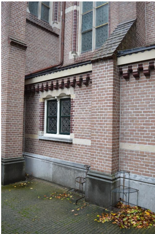
Links: een travee van de zuidelijke gang tegen de kapel (1895). Ten behoeve van deze gang zijn de steunberen verbreed en voorzien van doorgangen. Elke travee is ingevuld met een eenlaags aanbouw. Rechts: de bovenste verdieping van de zuidelijke traptoren, geleed door ronde pilasters en een boogfries van profielstenen.
