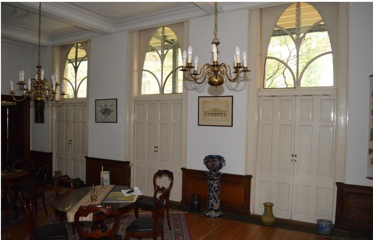
De vensterwand in de ontvangstkamer op de begane grond van het landhuis, bestaande uit hoge deurkozijnen met schuifluiken en sierlijke vroeg-19 de -eeuwse bovenlichten.
