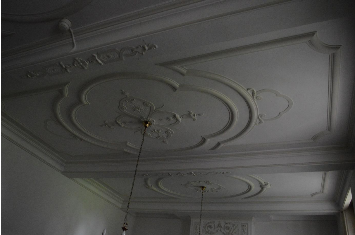
Het stucplafond in de ontvangstruimte uit de vroege 18 de eeuw, voorzien van decoraties in Lodewijk-XIV-stijl/ regencestijl. De verdeling in velden wijst op een bovenliggende balklaag van moer- en kinderbinten (17 de eeuw).
