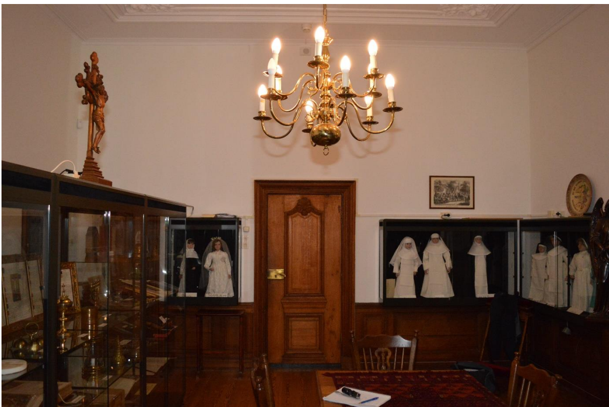
Overzicht van de museumkamer op de begane grond van het landhuis, gezien naar de gangwand. Herkenbaar is een 18 de -eeuwse paneellambrisering en een deurkozijn met een eikenhouten paneeldeur met sierlijk snijwerk (Lodewijk-XIV-stijl).
